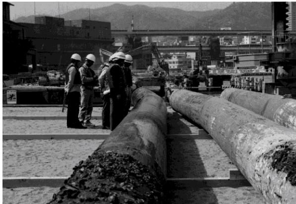
写真-2.5 被災した栈橋式岸壁の杭
