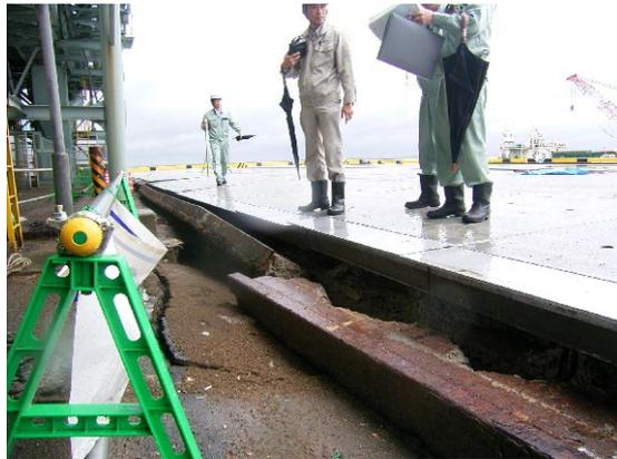
写真-2.6 博多港・須崎埠頭の被害状況
