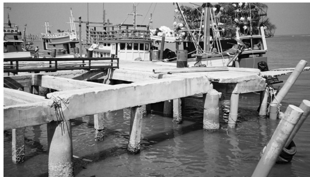
写真－1 修理によって使用された栈橋
