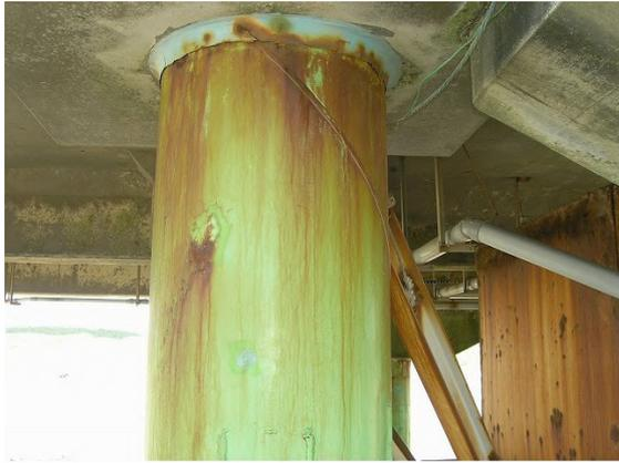
写真-D.67 鋼管杭No.K10 ガラスフレークポリエステル樹脂/フッ素樹脂塗装工法(表-C.72 参照)
