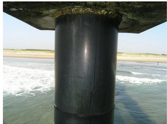
写真-D.22 鋼管杭 No. 13 ペトロラタムライニング+ポリ
