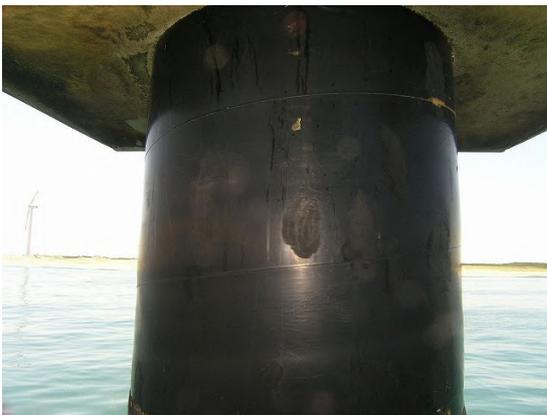
写真-D.47 鋼管杭No.31 ポリエチレンライニング工法(表-C.52 参照)
