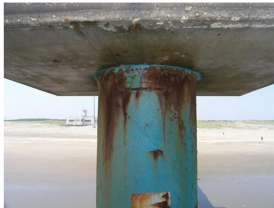
写真-D.8 鋼管杭 No.6 水中硬化型ライニング工法(表-C.8 参照)
