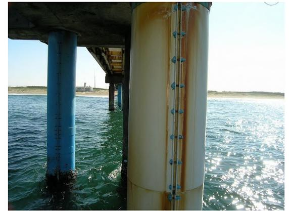
写真-D.34 鋼管杭 No. 20 ペトロラタムライニング+耐食
