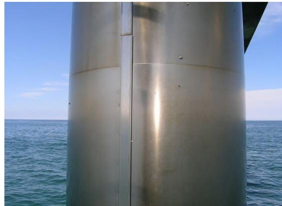
写真-D.46 鋼管杭 No.29 ペトロラタムライニング+チタンカバー工法 [TP 工法] (表-C.50 参照)
