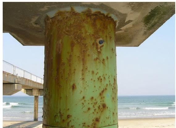
写真-D.66 鋼管杭 No. K9 水系厚膜防食塗料/フッ素樹脂
