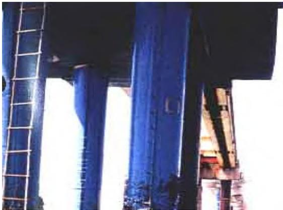
写真-D.33 鋼管杭 No. 20 セメントモルタル/FRP カバー
