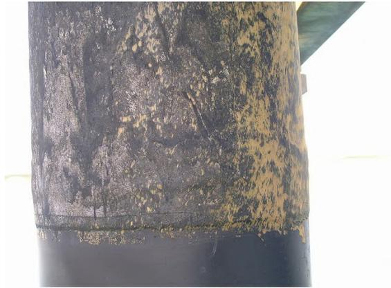
写真-D.56 鋼管杭 No. 34’ K シート融着+FRP カバー補修法 (表-C.61 参照)
