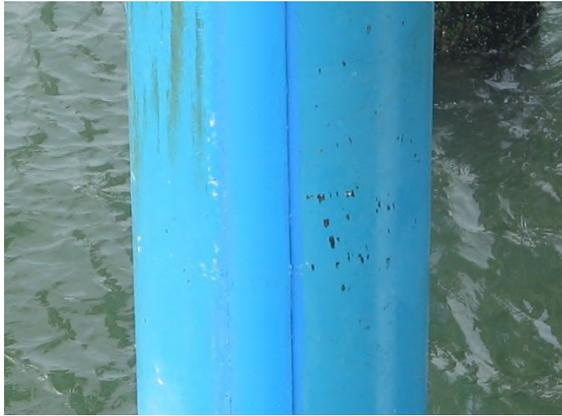
写真-D.37 鋼管杭 No. 21 特殊ウレタン樹脂新被覆工法(表-C.37 参照)
