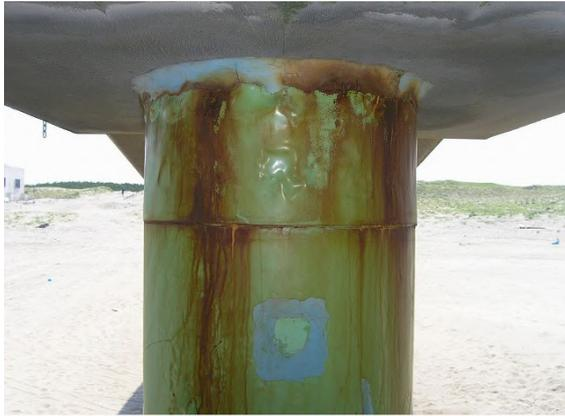
写真-D.1 鋼管杭 No.1 防食シート接着ライニング工法 (表-C.1 参照)
