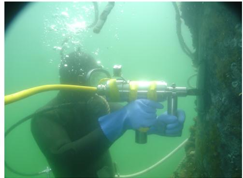
写真-B.17 超音波溶着法によるポリエチレンライ
