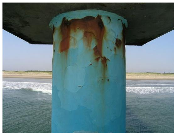
写真-D.26 鋼管杭 No. 15 水中硬化型ライニング工法(表
