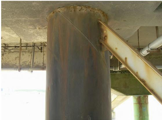
写真-D.63 鋼管杭 No. K6 タールエポキシ樹脂塗装工法(表
