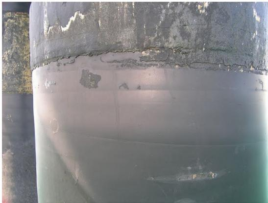
写真-D.57 鋼管杭 No. 35’ K シート融着+FRP カバー補修法 (表-C.62 参照)
