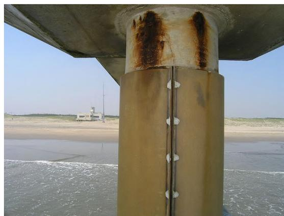
写真-D.12 鋼管杭No.8 セメントモルタル/FRP カバー工法(表-C.12 参照)
