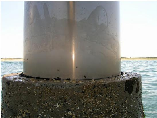
写真-D.45 鋼管杭No.29 CRUS 工法(補強と防食を併せ持つ工法)(表-C.49 参照)
