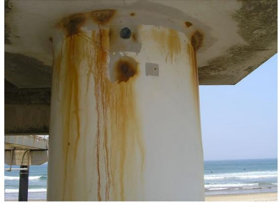
写真-D.62 鋼管杭 No. K5 厚膜型無機ジンク/エポキシ/
