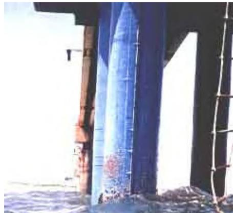
写真-D.36 鋼管杭No. 21 防食テープ/FRP カバー工法(表
