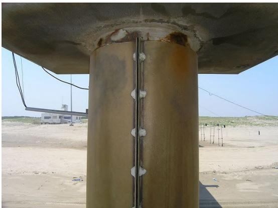
写真-D.5 鋼管杭 No.4 セメントモルタル/FRP カバー工法(表-C.5 参照)
