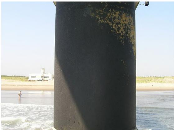
写真-D.21 鋼管杭 No. 12 ペトロラタムライニング+FRPP
