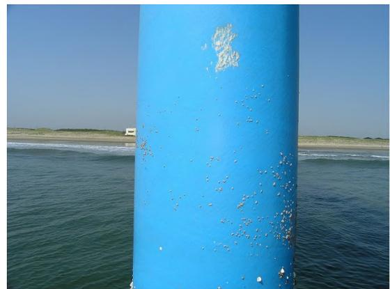
写真-D.24 鋼管杭 No. 14 ペトロラタムライニング+ポリ
