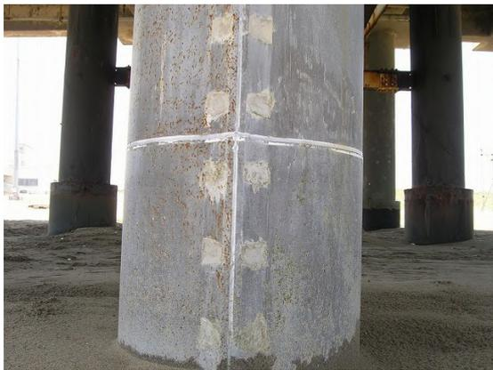
写真-D.3 鋼管杭No.2 ダクトカバーモルタルライニング工法(表-C.3 参照)
