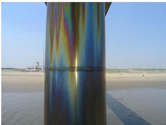
写真-D.9 鋼管杭No.6 ペトロラタムライニング+チタンカバー工法 [一体成型防食工法(B 法)] (表-C.9 参照)
