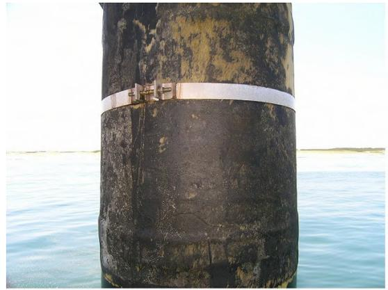
写真-D.52 鋼管杭 No.31' Kシート+CBテープ巻き+FRPカバー補修法(表-C.57 参照)
