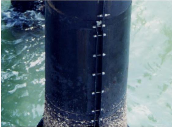
写真-D.31 鋼管杭 No. 19 ペトロラタムライニング+FRPP
