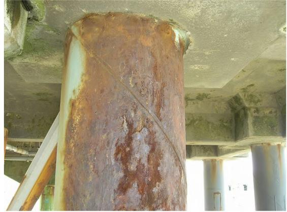
写真-D.68 鋼管杭 No.K11 湿潤面用エポキシ樹脂塗装工法(表-C.73 参照)
