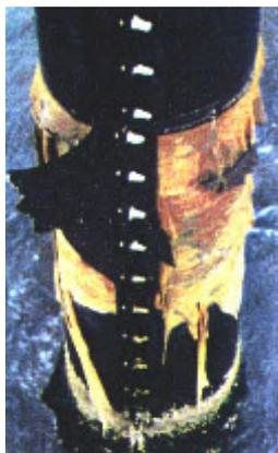
写真-D.23 鋼管杭 No. 13 ペトロラタムライニング+FRV
