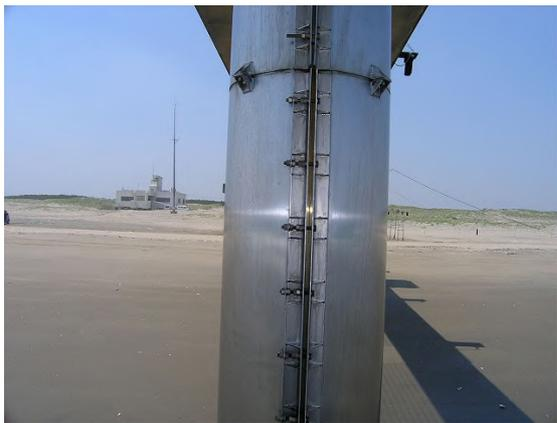
写真-D.7 鋼管杭No.5 ペトロラタムライニング+耐海水性ステンレス鋼カバー工法(表-C.7 参照)
