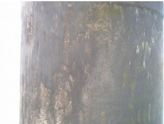
写真-D.53 鋼管杭 No.32' Kシート+CBテープ巻き+FRPカバー補修法(表-C.58 参照)
