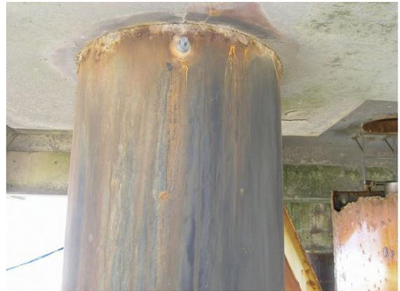
写真-D.64 鋼管杭 No. K7 タールエポキシ樹脂塗装工法
