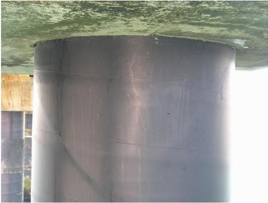
写真-D.49 鋼管杭No.33 ポリエチレンライニング工法(表-C.54 参照)
