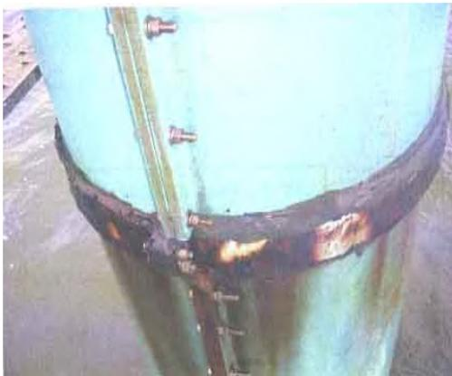
写真-D.41 鋼管杭 No. 25 ペトロラタムライニング+FRP樹脂カバー工法[一体成型防食工法(A 法)] (表-C.44 参照)
