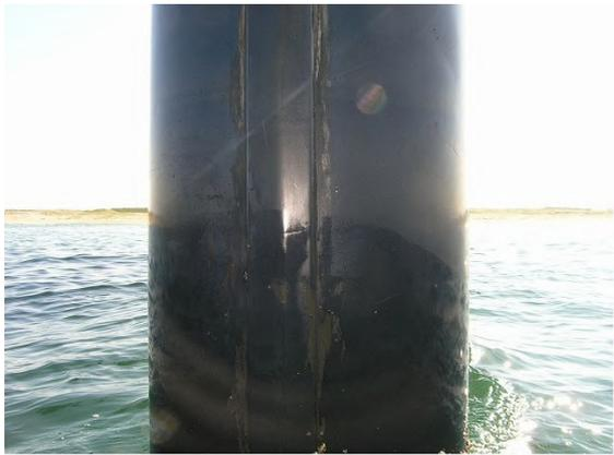
写真-D.39 鋼管杭 No. 22 ペトロラタムライニング+FRP樹脂カバー工法 [PTC-FL 工法] (表-C.39 参照)
