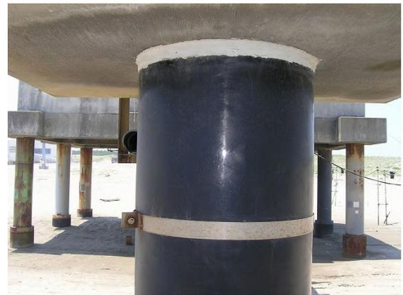
写真-D.4 鋼管杭 No.3 ペトラタムライニング+ポリエチレン樹脂カバー工法 [PE 工法] (表-C.4 参照)
