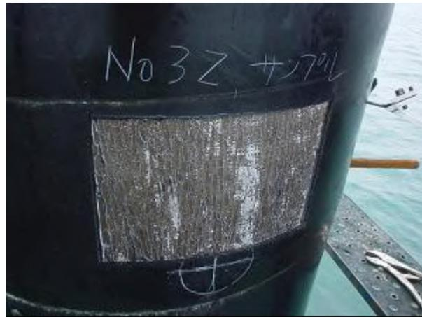
写真-B.8 ポリエチレンライニング下の鋼材表面(鋼管杭 No. 32) (写真-3.4 参照)
