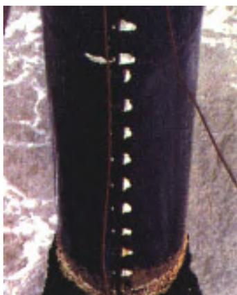
写真-D.25 鋼管杭 No. 14 ペトロラタムライニング+FRV
