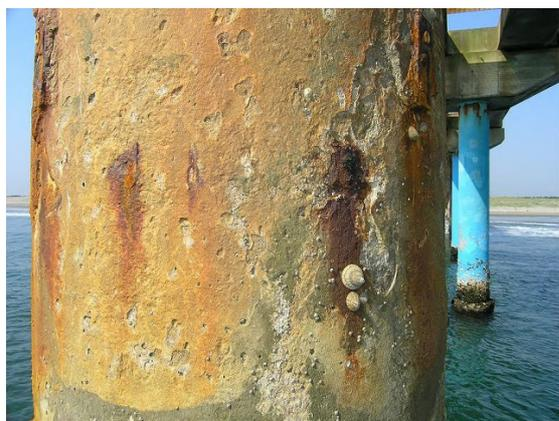
写真-D.29 鋼管杭 No. 17 GRC 補強カバー工法(表-C.29 参
