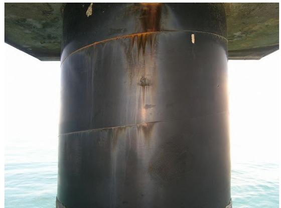
写真-D.48 鋼管杭 No.32 ポリエチレンライニング工法(表-C.53 参照)
