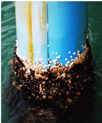
写真-D.35 鋼管杭No. 21 特殊ウレタン樹脂新被覆工法(表
