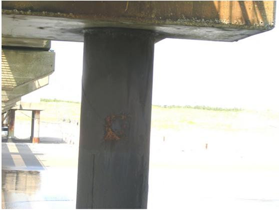
写真-D.13 鋼管杭 No. 9 水中硬化型ライニング工法 [A 法]
