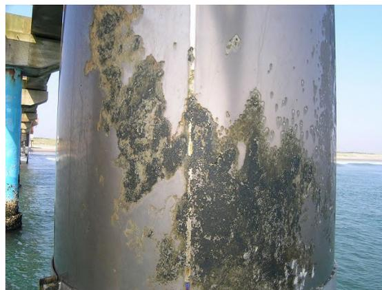
写真-D.28 鋼管杭 No. 16 チタンカバーモルタルライニング
