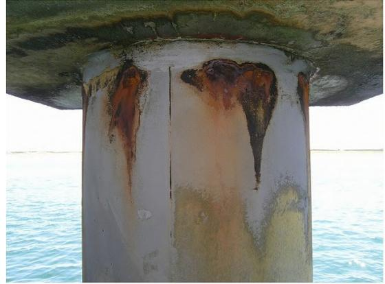
写真-D.44 鋼管杭 No.28 極厚マスチック防食工法(型枠注型工法)(表-C.48 参照)
