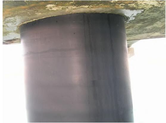
写真-D.50 鋼管杭 No.34 ポリエチレンライニング工法(表-C.55 参照)
