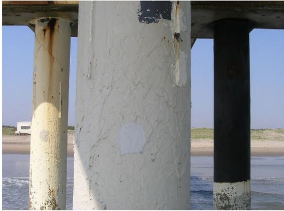
写真-D.19 鋼管杭 No. 11 水中硬化型ライニング工法 [C
