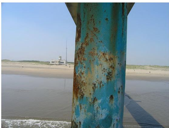
写真-D.11 鋼管杭 No.7 水中硬化型ライニング工法(ペイント+パテタイプ)(表-C.11 参照)
