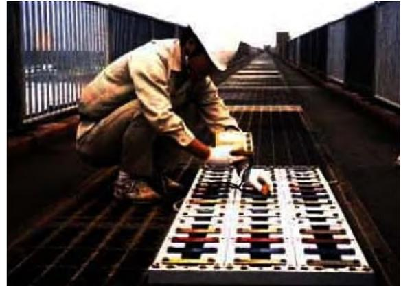
写真-D.70 栈 100 金属溶射防食工法(表-C.75 参照)
