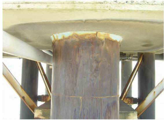
写真-D.2 鋼管杭 No.2 防食シート接着ライニング工法 (表-C.2 参照)
