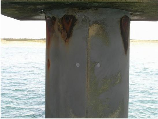
写真-D.43 鋼管杭No.27 極厚マスチック防食工法(型枠注型工法)(表-C.47 参照)
