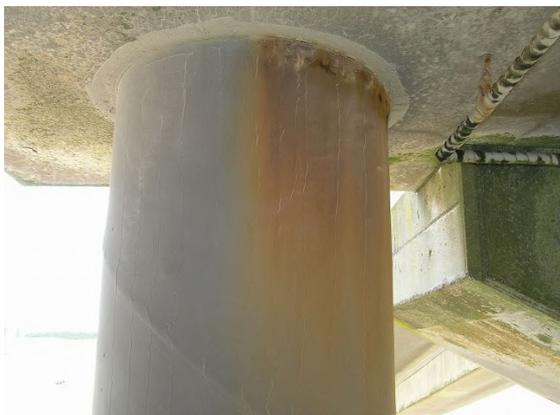
写真-D.59 鋼管杭 No. K2 超厚膜型エポキシ樹脂塗装工法 (表-C.64 参照)
