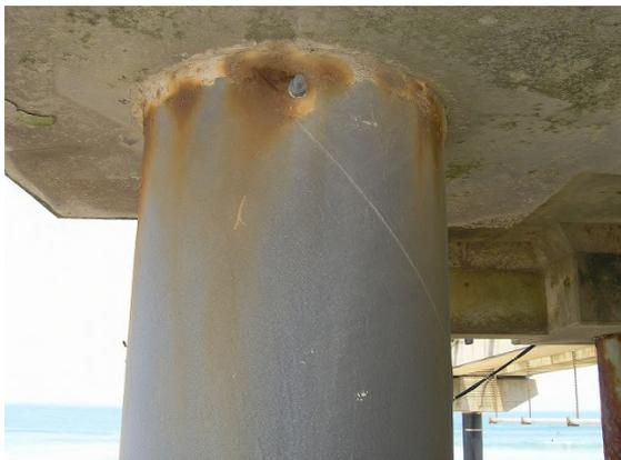
写真-D.65 鋼管杭 No. K8 ガラスフレークエポキシ樹脂塗
