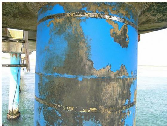
写真-D.27 鋼管杭 No. 16 ペトロラタムライニング+アクリル
