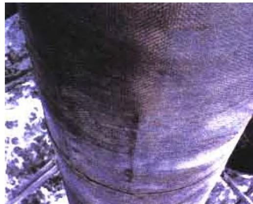
写真-D.6 鋼管杭 No.5 水中硬化型ライニング工法(表-C.6 参照)
