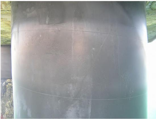
写真-D.51 鋼管杭No.35 ポリエチレンライニング工法(表-C.56 参照)
