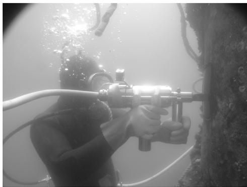
写真-4.2 超音波溶着法によるポリエチレンライニングの補修状況 (写真-B.17 参照)
