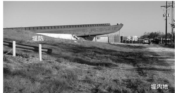
写真-3.10 Inner Harbor Navigation Canal の堤防 (図-2.14の地点⑦) に乗り上げたバージ
