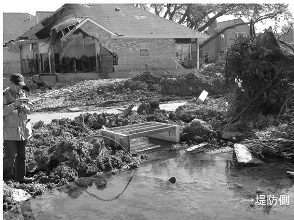
(d) 応急処置された堤防からの漏水
