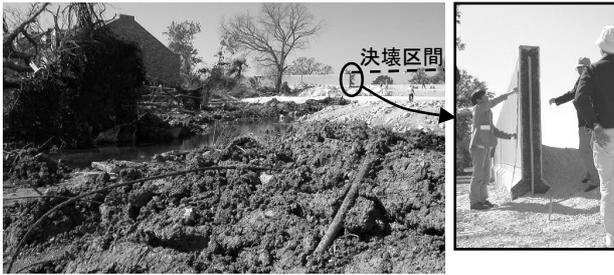
(a) 破堤区間と堤防の断面
