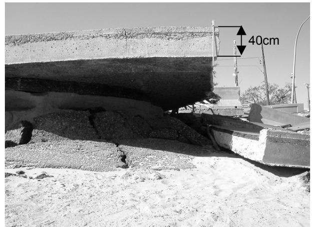
(b) 取り付け部の地盤の洗掘
