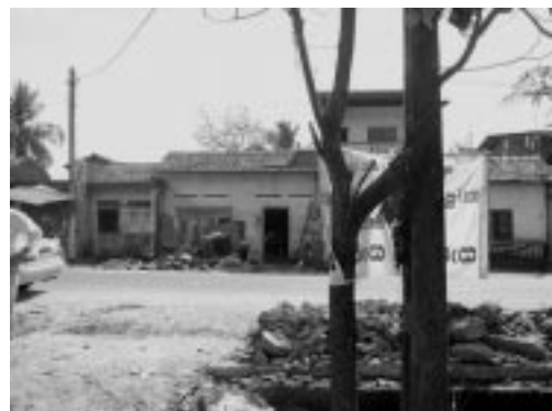
写真-3.14 図-3.6に示した海沿いの残存した建物（撮影：富田）
