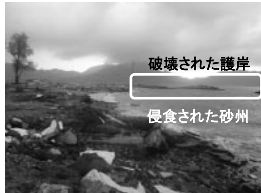
写真-5.7 津波による侵食 (撮影：富田)
