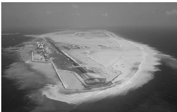
写真-4.2 浸水した国際空港の全景 （提供：Mr. Todd Rempel）
