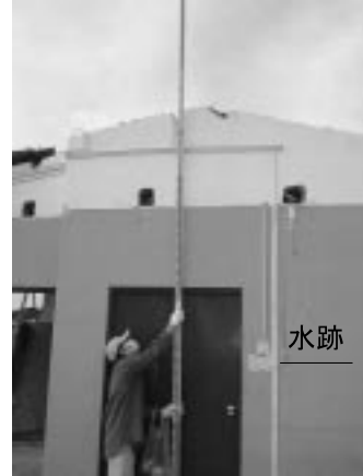
写真-3.3 壁に残る水跡（撮影：富田）
