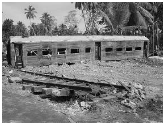
写真-3.10 津波により被災した列車（撮影：安田）
