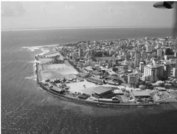
写真-4.1 マレ島北東部の護岸（提供：Mr. Todd Rempel）
