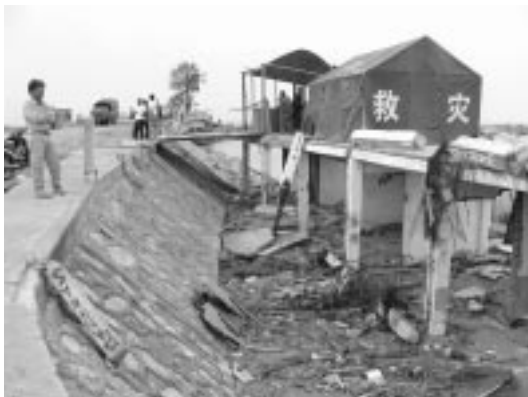
写真-5.3 盛土が防護した建物の一部 (撮影：菅野)
