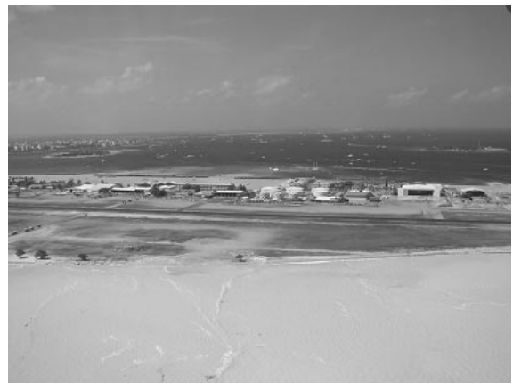
写真-4.3 浸水した国際空港の東部 （提供：Mr. Todd Rempel）
