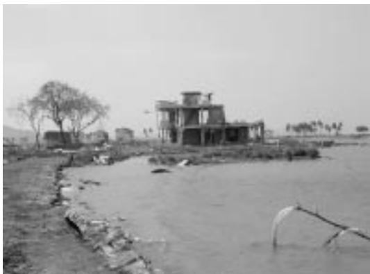
写真-5.2 大破したコンクリートの家屋 (撮影：富田)
