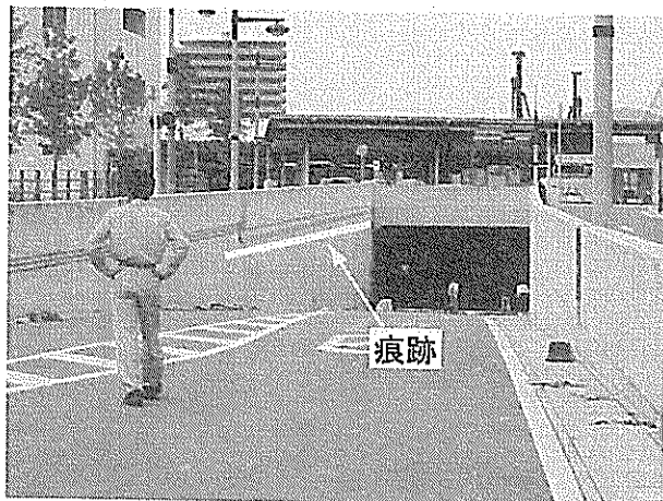
図-4.18(a) 高松駅下の道路
