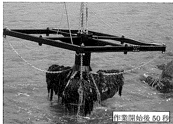
写真-25 海中ブロックの吊り上げ作業中
