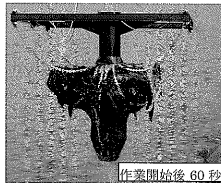
写真-26 吊り上げ作業完了
