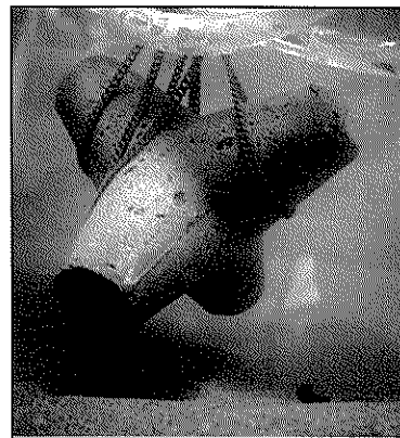
写真-21 ブロック吊り上げ
