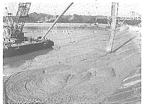
写真-5-5 セメント処理土の保護土層の打設
