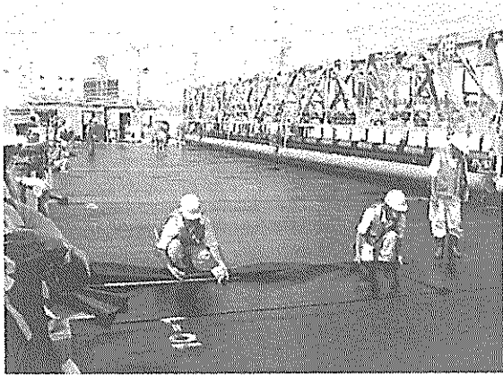
写真-5-1 遮水シート溶着状況 1
