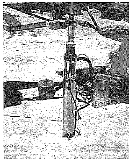
写真-1 新 A 滑走路で使用中のものと同じ換振器
