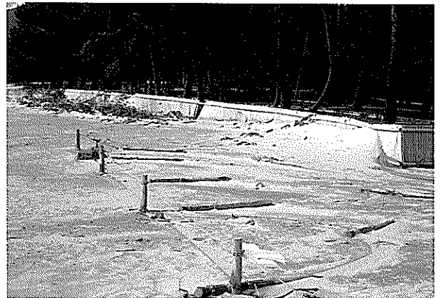
写真-4 防風垣前面の砂の堆積（1999年9月24日）
