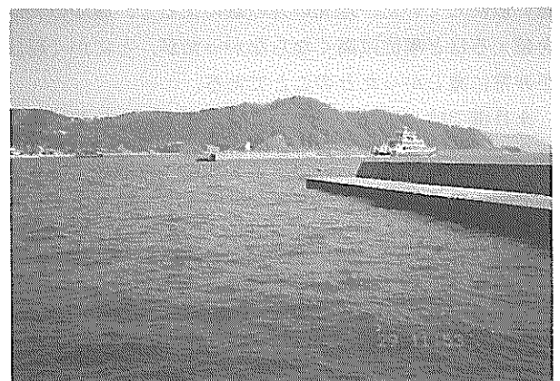
写真-5.4 大道港の防波堤(沖に離岸堤のように見える防波堤は、もともとは手前の防波堤とつながっていた。)
