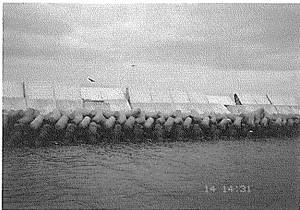
写真-6.1 新門司港沖合の埋立護岸 (撮影時の潮位は C.D.L.+2.3m である。)
