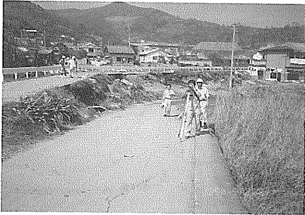
写真-5.9 和田船溜の東側の堤防(右手にある家屋の一階部分も浸水した。)
