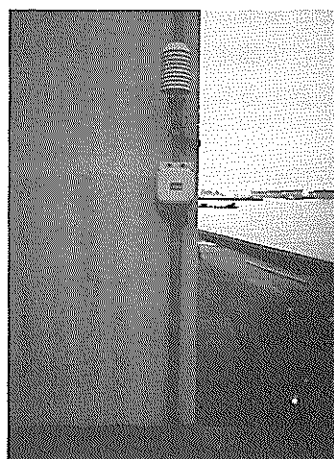
写真-8 温度計発信器及び接続箱
