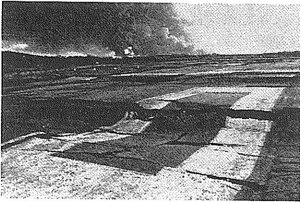
写真-1 新潟空港B滑走路の被害状況(1964年新潟地震)
