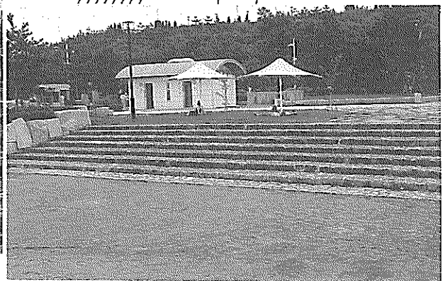
④アプローチとなる階段護岸は石張りで整備されている。
