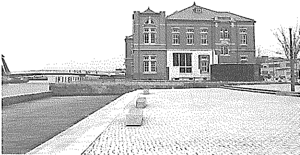
観潮広場の潮が引いた状態 (前半調査開始11:15頃)
