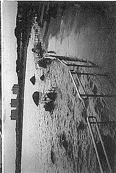
②親水護岸における階段と景石の配置。階段部のコンクリート表面は洗い出し仕上
