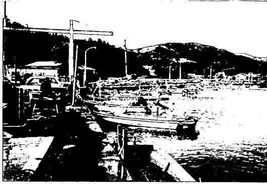
写真-4.4 三崎漁港の岸壁
