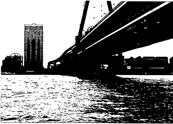
写真-25 六甲大橋 (ポートアイランド側を望む)
