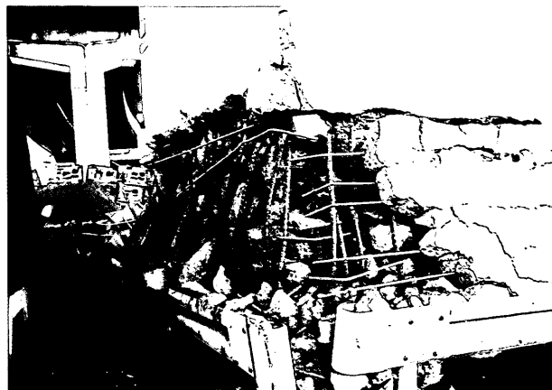
写真-69 主鉄筋の座屈と帯鉄筋の脱落 (P74)
