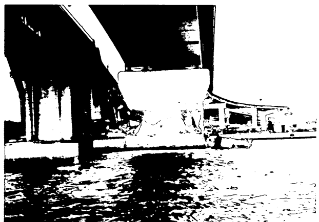
写真-18 第2摩耶大橋P3橋脚（港幹P70）南西（左側は摩耶大橋P8橋脚）
