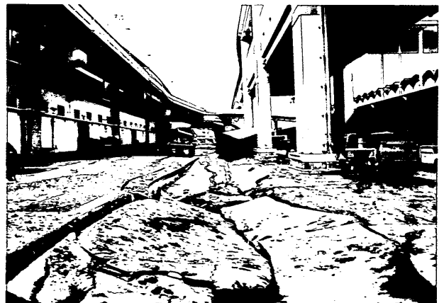
写真-77 第4突堤での液状化
