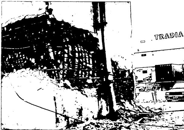
写真-74 港湾幹線道路橋脚P86
