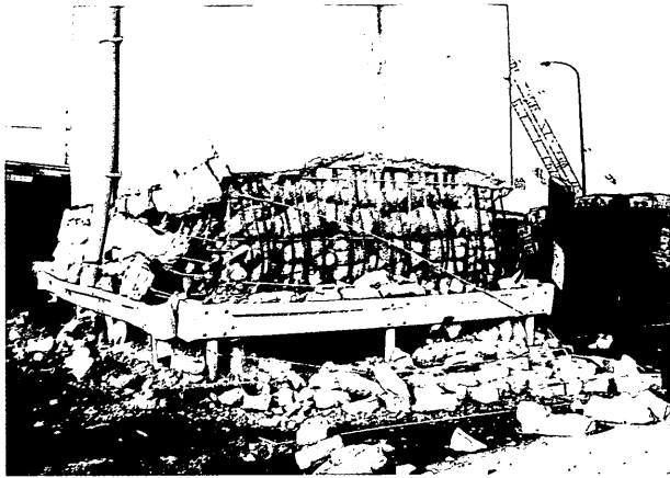
写真-67 港湾幹線道路橋脚P74
