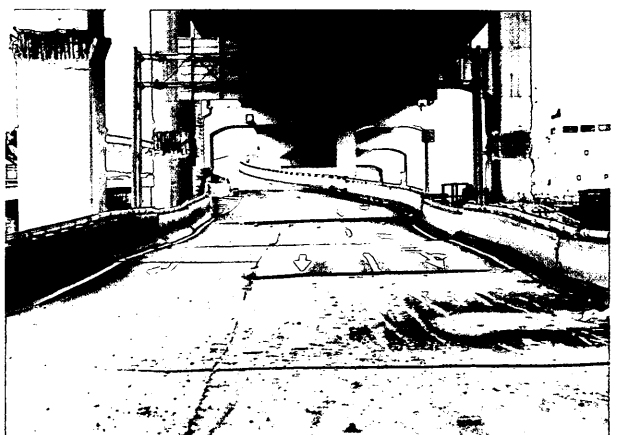
写真-48 港湾幹線道路神戸大橋からのオフランプ (第4突堤) (手前からP25,P24,...)
