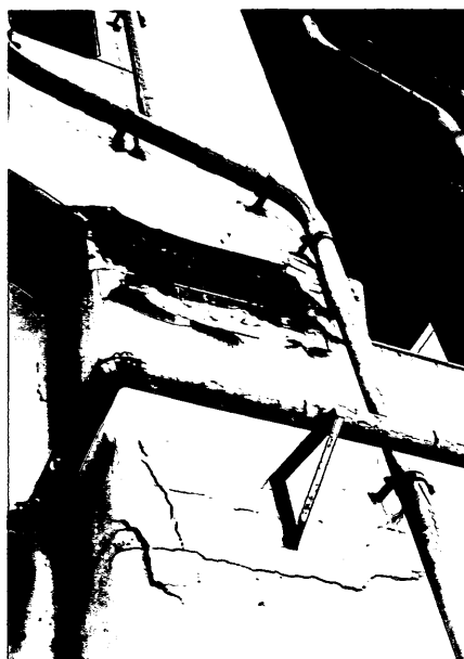
写真-40 港湾幹線道路橋脚P17東柱
