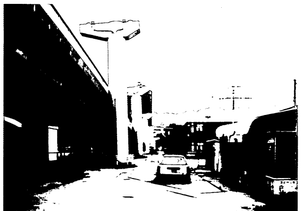
写真-78 ポートライナー橋脚(第4突堤) (桁はすでに撤去されている)
