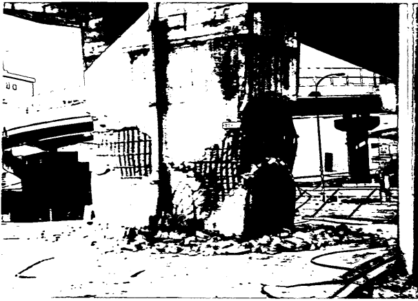
写真-73 港湾幹線道路橋脚P85
