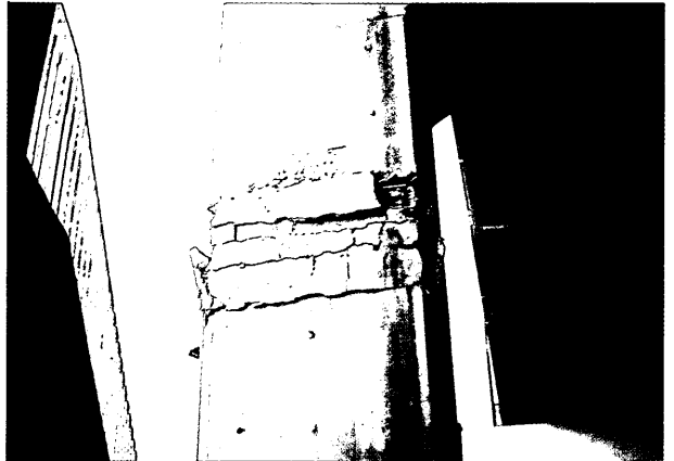
写真-47 港湾幹線道路橋脚P26東柱
