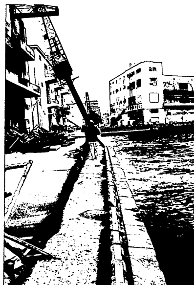
写真-4.1 ジブクレーンの倒壊(新港埠頭)
