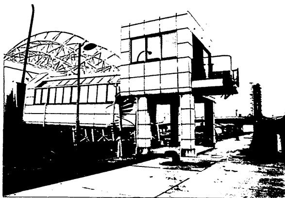
写真-3.3 人道橋の脱落(六甲No.1)
