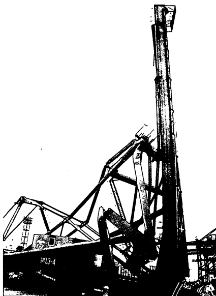
写真-2.1 クレーンの崩壊 (RC3-4)
