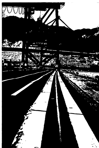
写真-2.5 ブームの外れ (摩耶No.4)
