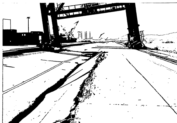
写真-2.4 走行装置の脱落 (六甲No.1)
