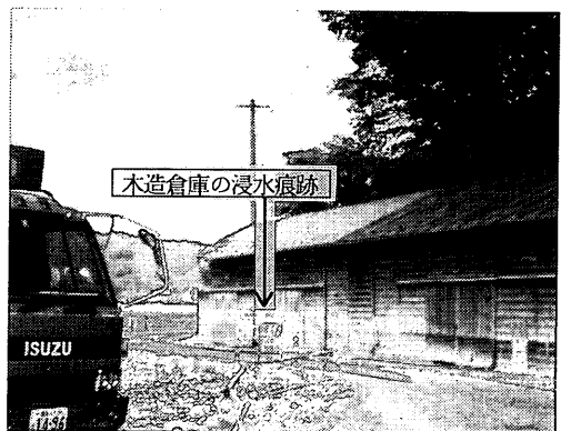
写真-5.12 堀内地区作業小屋の痕跡
