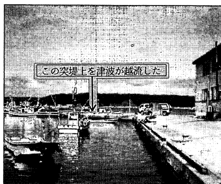
写真-5.8 久慈港玉の脇地区の状況
