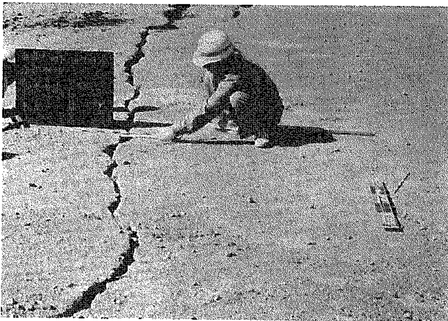
写真—3.2.23 亀裂（函館港、若松地区道路護岸、護岸背後地盤）
