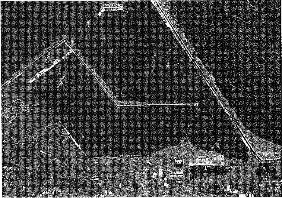
写真—4.1.1 被災前の青苗漁港の全景
