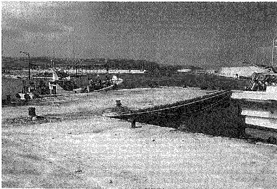
写真—4.1.19 被災後の施設全景 (育苗漁港、①中央埠頭 (突堤))
