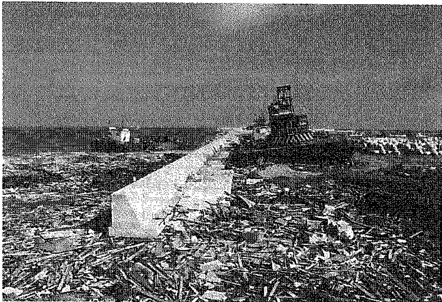
写真-4.1.27 被災後の施設全景 (背苗漁港、④東護岸)
