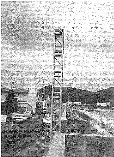
写真-2 観測タワー (測点1-T-1)
