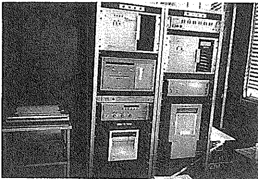
(5) 監視局観測機器
