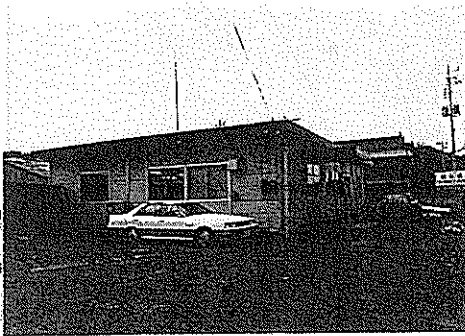
(5) 監視局(三岡工場)全景
