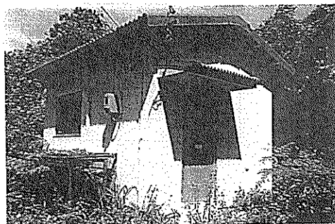
(4)藍島観測局全景
