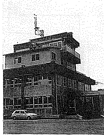
(5)監視局風観測施設
