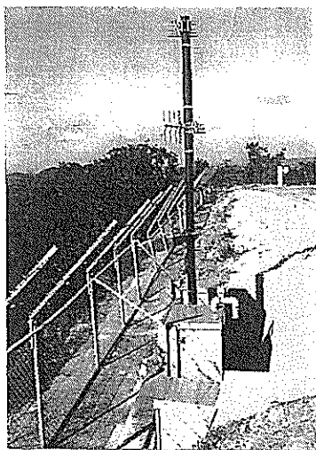
(3) 無線中継局(西山)全景
