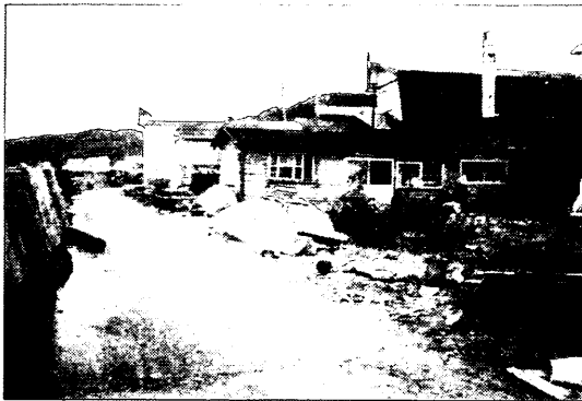
写真-6.17 (17) 鍋釣岩付近の被災状況 民家が一軒おきに壊滅的被害を受けた
