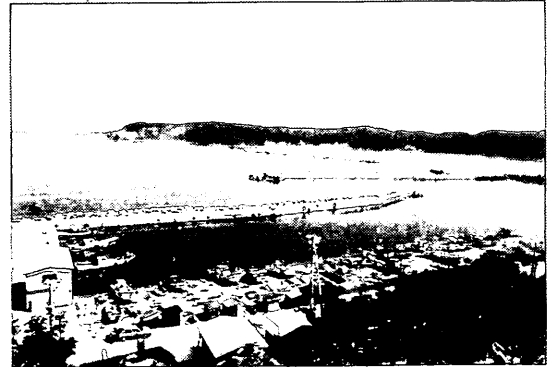
写真-6.32 秋田県 戸賀港 塩戸地区
