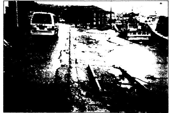
写真-6.17 (6) 奥尻港の被災状況 物揚場のエプロン沈下, 道路舗装上のクラック
