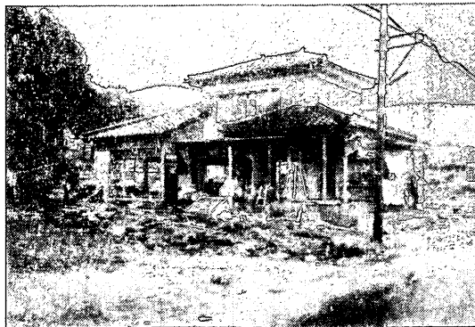
写真-6.17 (10) 奥尻港北部の被災状況 大きな被害を受けた家屋
