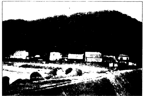
写真-6.17 (18) 奥尻港南部の状況 津波による被害は大きくない
