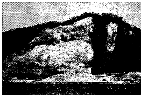
写真-6.18 奥尻港背後の土砂崩れ現場
