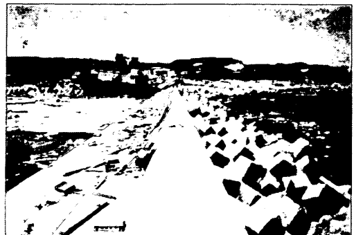
写真-7.1 (3) アスファルト舗装の剥離，青苗漁港東護岸背後
