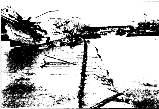
写真-6.17 (5) 奥尻港の被災状況 岸壁およびエプロンの沈下, 前出し 津波によりエプロンに乗り上げた漁船
