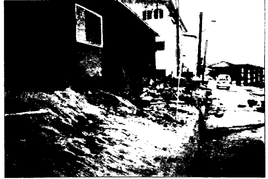
写真-6.17 (16) 奥尻港背後の民家の被災状況
