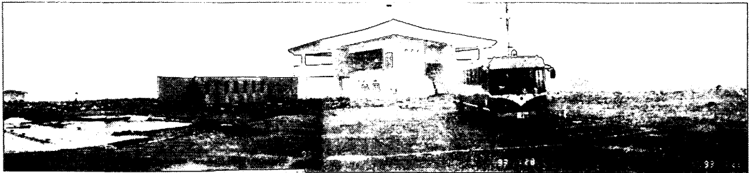
写真-6.22 賽の河原 鉄筋の構造物以外は津波により全壊した
