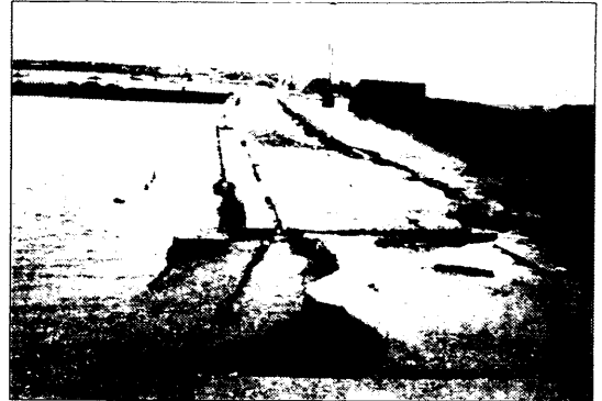
写真-6.17 (4) 奥尻港の被災状況 物揚場のエプロン沈下
