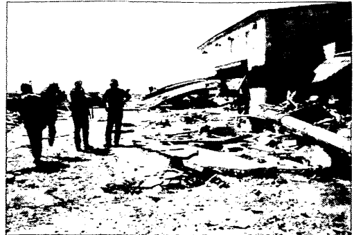
写真-7.1 (1) アスファルト舗装の剥離，青苗漁港4.0m物揚場背後
