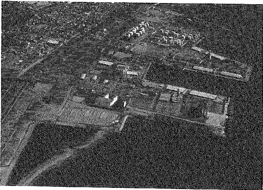
写真—3.3.12 第3埠頭地区着工前（昭和59年10月）
