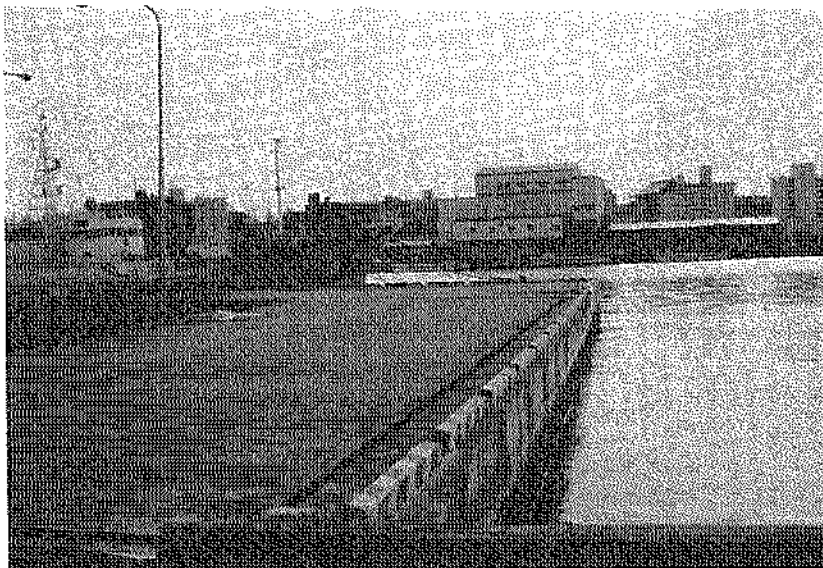
写真-3.2.9 幸町地区、②物揚場(-2.0m)に隣接する護岸
