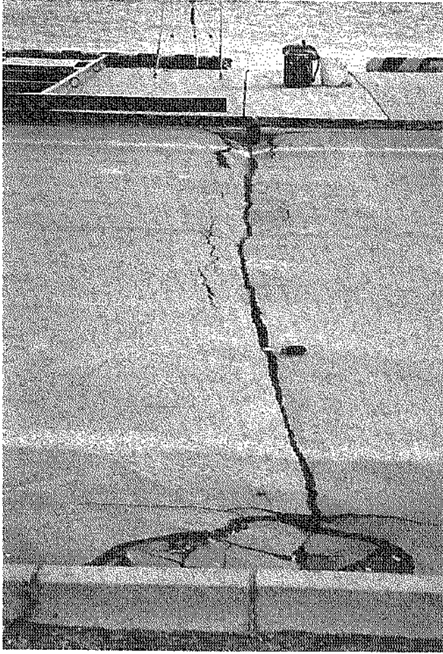
写真—5.3.2 千代ノ漁港 (④道路)
