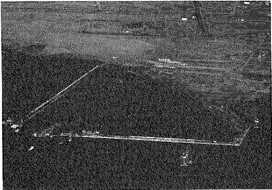
写真—3.3.10 第2埠頭地区南侧・西側岸壁建設状況（昭和56年11月）
