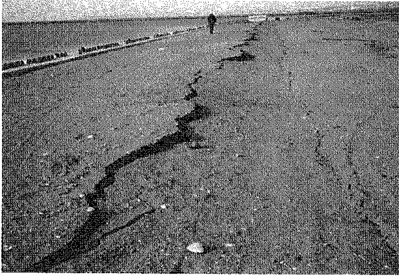
写真-3.3.55 岸壁背後地盤の沈下状況 (第3埠頭地区, ㊸物揚場(-4.0m))
