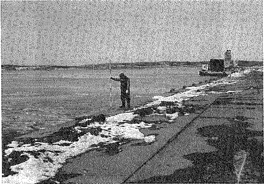
写真—5.1.17 厚岸漁港 (㊹-2.0m物揚場)
