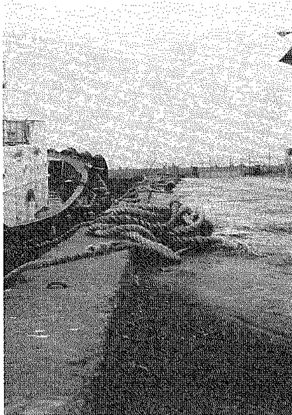
写真—3.3.18 エプロン沈下状況（船溜・漁港地区，物揚場（-3.0m），1993年4月撮影）
