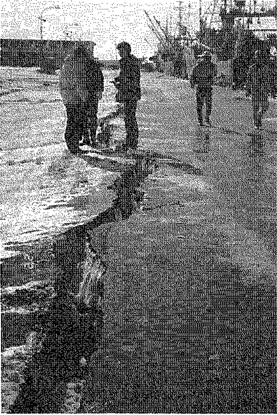
写真—3.2.45 被災状況漁業埠頭③西側岸壁 (-7.0m)
