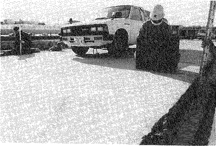
写真-5.2.3 大樹漁港 (㊸-3.5m岸壁)
