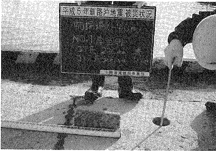
写真—4.2.3 エプロン舗装コア採取状況（十勝港，③物揚場（南—4.0m））
