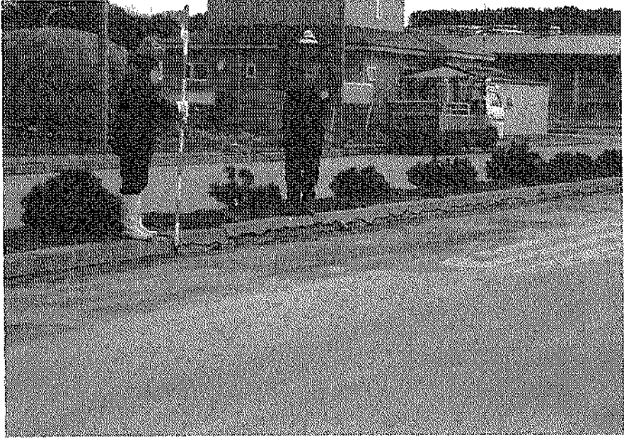
写真—5.1.28 厚岸漁港 (㊤道路)
