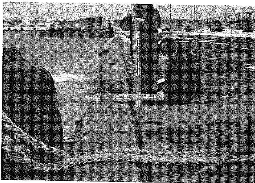
写真—5.1.15 厚岸漁港 (⑧-3.0m岸壁)
