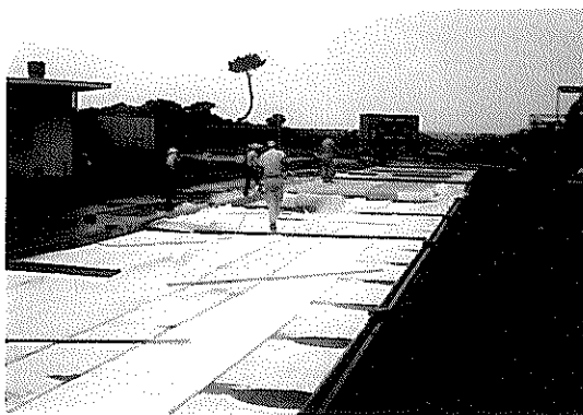
写真-5 散水養生
