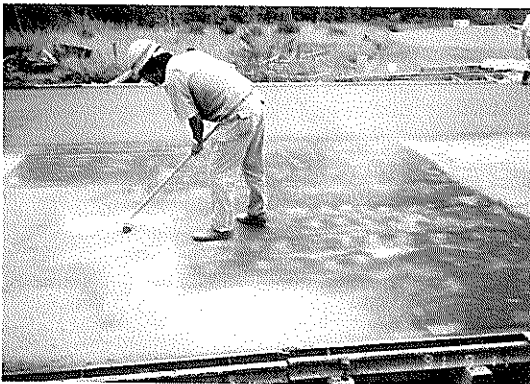
写真-21 骨材露出工法の施工
