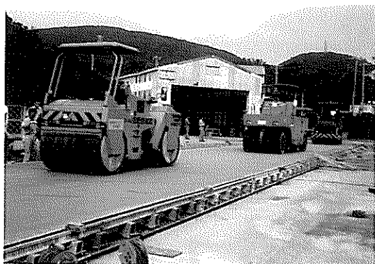
写真-3 RCCの仕上げ転圧
