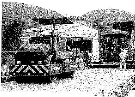
写真-2 RCCの初転圧と二次転圧
