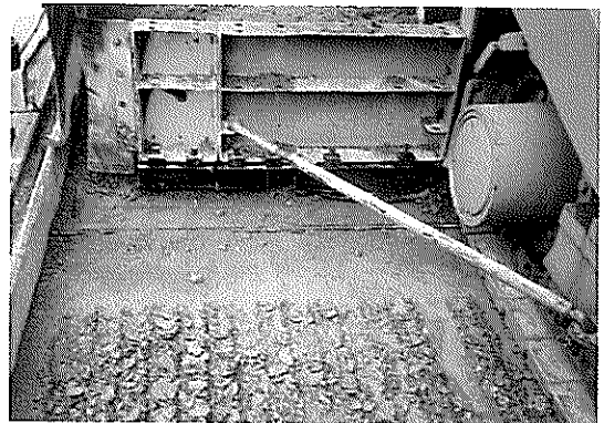
写真-18 スリッパーの目地の施工
