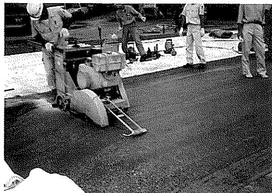
写真-10 施工目地の切り込み
