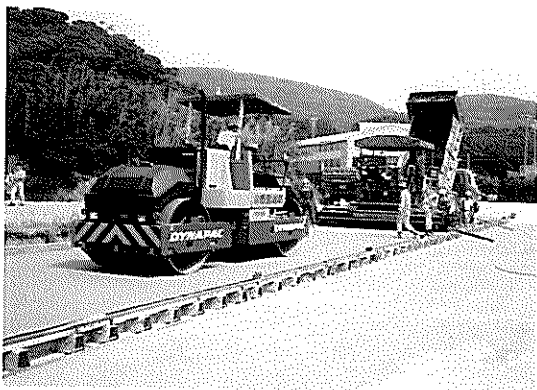
写真-1 CTBの施工
