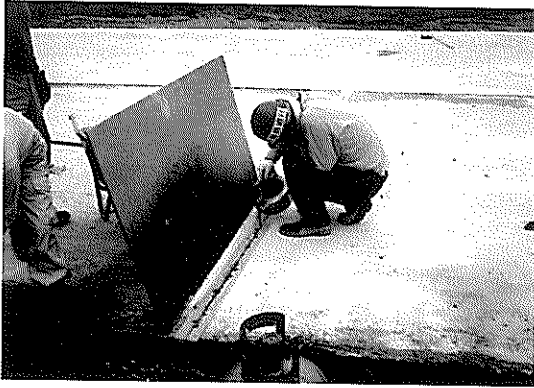
写真-13 目地材の充填
