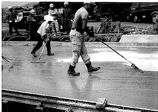
写真-8 下層 RCC 表面のセメントペースト塗布
