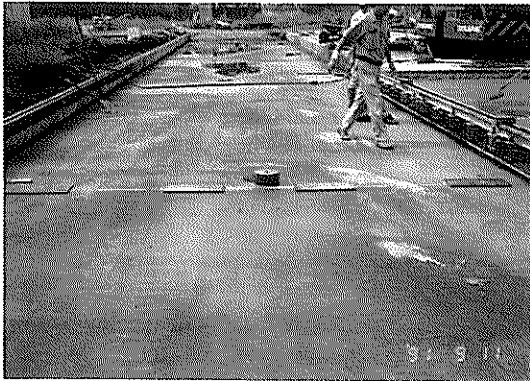
写真-20 横方向鉄板目地
