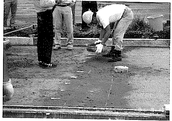
写真-16 スリッパー周囲の埋戻し
