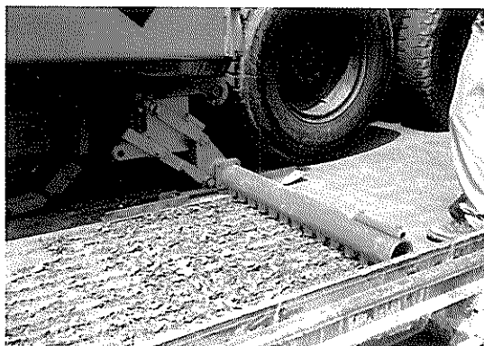
写真-7 下層 RCC 表面の掻きほぐし
