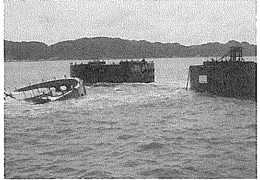
写真-1 滑動した二重円筒ケーソン
