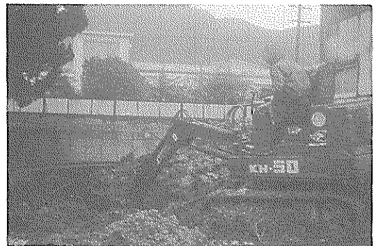
図一九 処理土の掘出し
