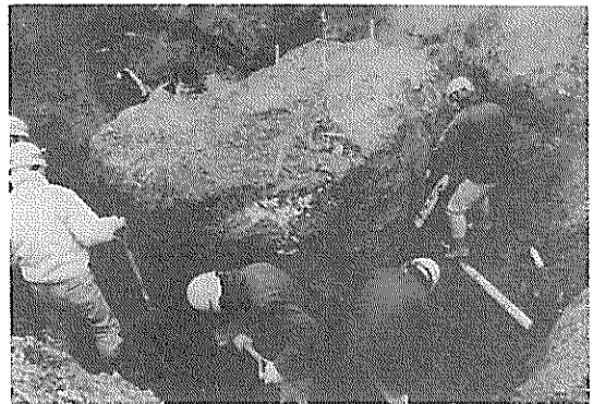
図-5 現地での掘削風景
