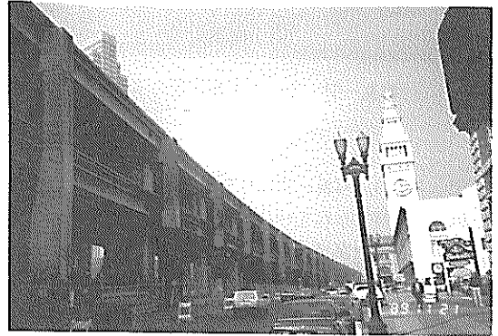
写真-47 フェリービルディングとエムバカデロ高架橋
