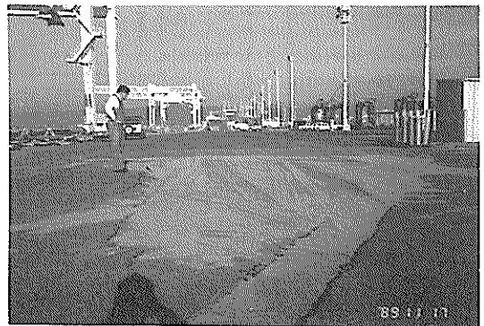
写真-9 7th Street ターミナルの液状化(バース37)
