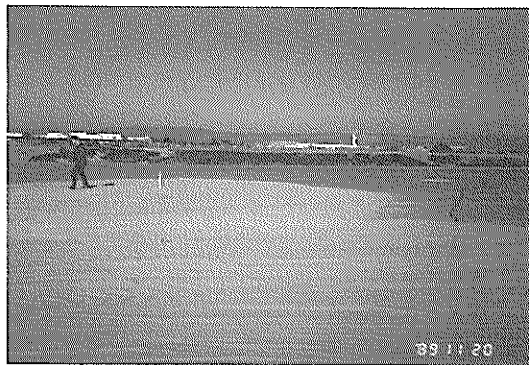
写真-57 オークランド空港の滑走路に出現した噴砂
