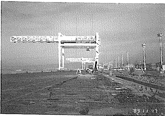
写真-7 7th Street ターミナルの被害(バース37)
