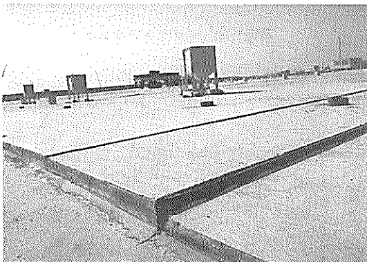
写真-10 リフトアップの状況
