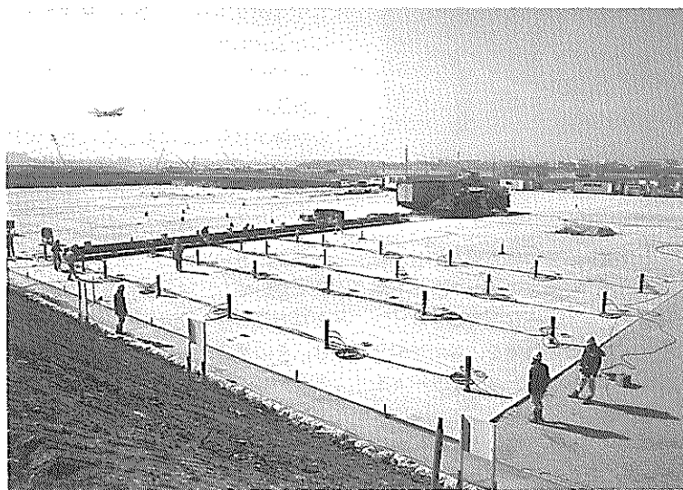
写真-4 試験舗装の全景
