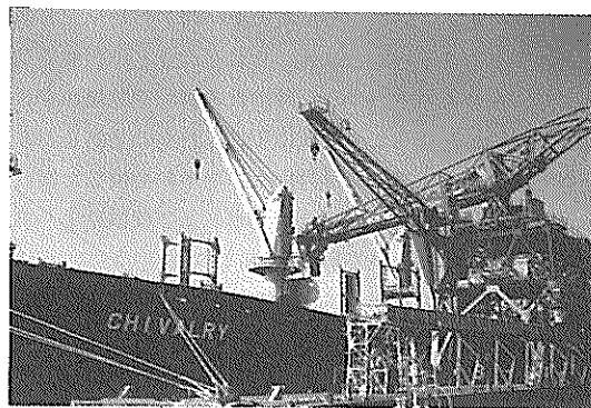
写真-7 機械式連続アンローダによる荷役状況の外観
