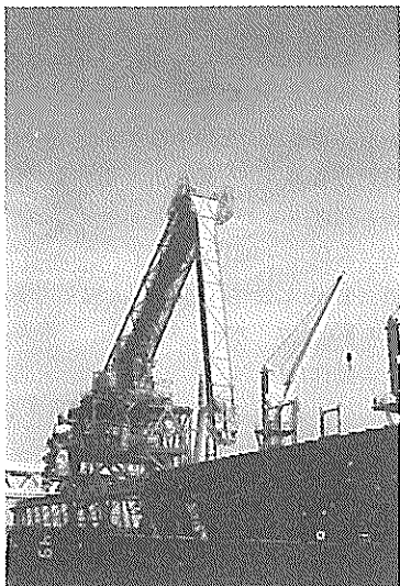
写真-2 機械式連続アンローダの外観
