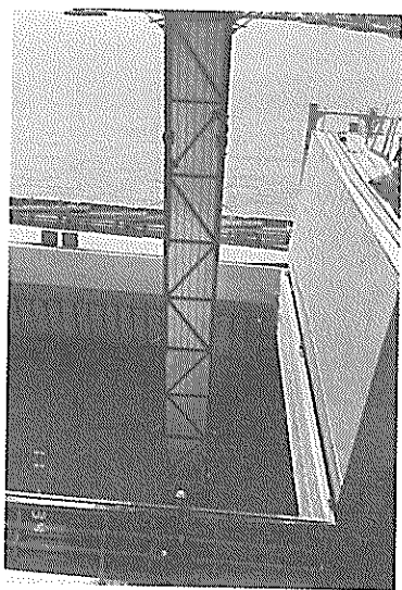
写真-18 機械式連続アンローダによる一定時間経過後の荷役作業時の様子（1日目 11:34' 2番船倉）
