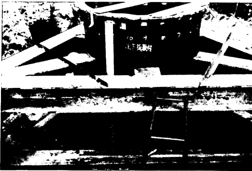
写真-5.9 地盤沈下測定ロッド
