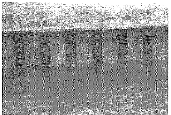
写真一 6 赤橙色のさびがごくわずかしかみられない 状態の鋼矢板面
