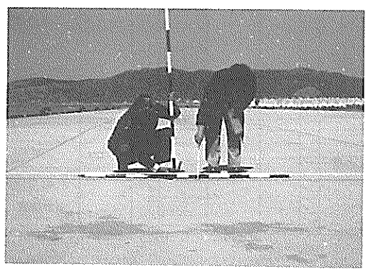
写真-1 北ふ頭-7.5m岸壁 (エプロン中央部の沈下)
