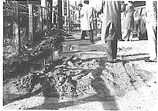
写真-12 西三号ふ頭臨港道路(噴砂)
