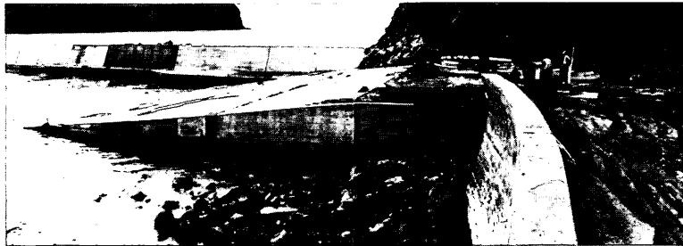
写真-5.104 関漁港：相川土木事務所提供
