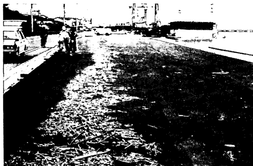
写真-5.67 能代港内-4m物揚場(測点⑬)のこん跡
