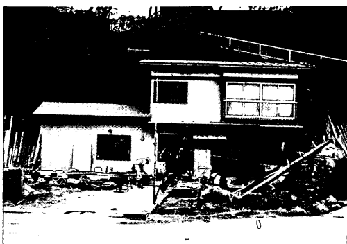
写真-5.57 八森漁港の家屋の被災状況
