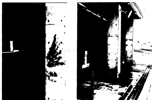
写真-5.35 荷さばき所の柱に示された最高水位のこん跡(風合瀬漁港)
