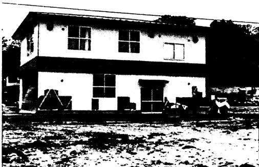
写真-5.85 湯ノ尻漁港漁民センターの被災状況(右側の消波ブロックは津波によって打ち上げられたもの。)(秋田県土木部港湾課提供)
