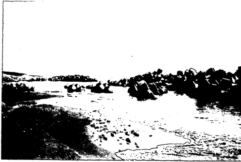
写真 - 5.62 浜田海岸の離岸堤の被災状況
