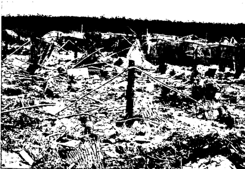
写真-5.73 落合海岸の津波のこの跡
