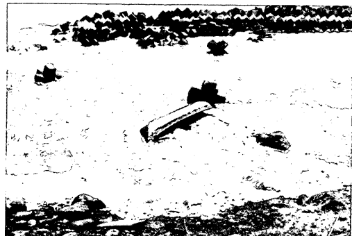
写真-5.90 津波による離岸堤の被災状況 (秋田県土木部港湾課提供)
