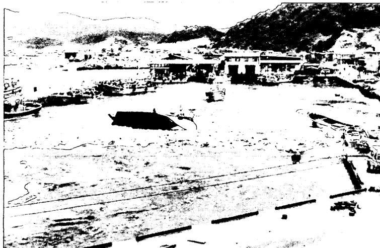
写真-5.25 小泊漁港港内直立消波ブロック波除堤 (漁船が転覆しているあたり)を越流する津波 (青森県西北地方漁港事務所小泊出張所提供)
