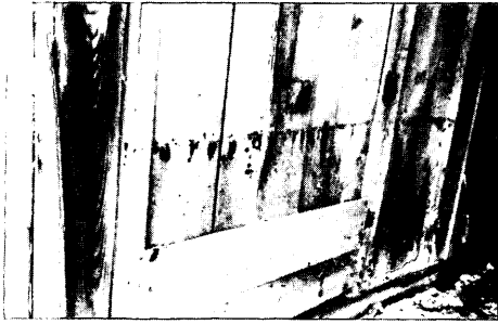
写真－5.39 深浦港内、磯崎川左岸の民家の のこん跡（測点㉗）
