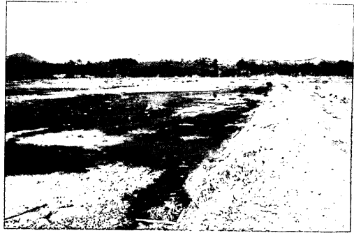
写真 - 5.63 埴川左岸の被災状況
