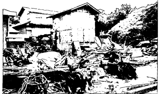
写真-5.53 岩館魚港分港の家屋の被災状況
