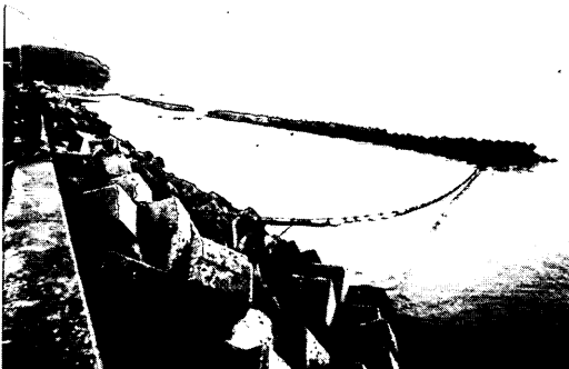
写真-5.21 福島漁港北側 (福島川左岸、踏査時撮影)
