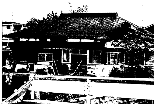
写真-5.82 北浦漁港第1防波堤基部の民家の被災状況
