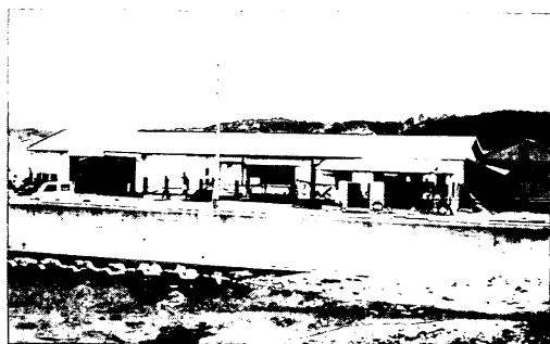
写真-5.83 荷さばき所の被災状況
