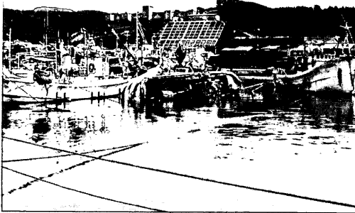
写真-5.46 深浦港内の漁船の被害 (青森県土木部港湾課提供)
