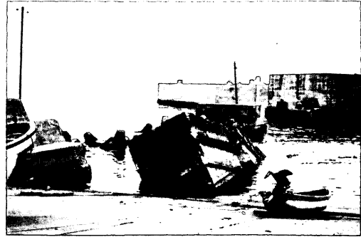
写真-5.56 岩館漁港東側突堤の被災状況
