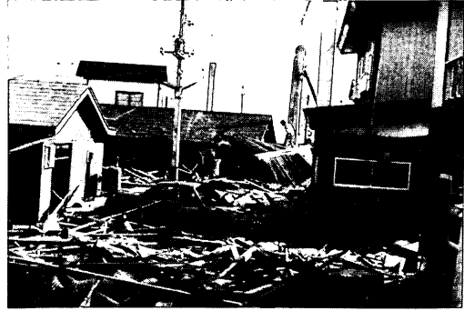
写真-5.5 青苗地区被災状況 (江差港湾建設事務所撮影)
