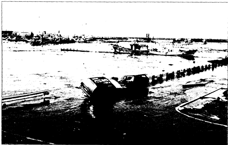
写真－5.41 深浦港埋立地の浸水状況(西側) (青森県土木部港湾課提供)
