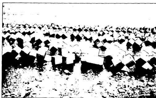
写真-5.84 八斗崎海岸離岸堤の被災状況
