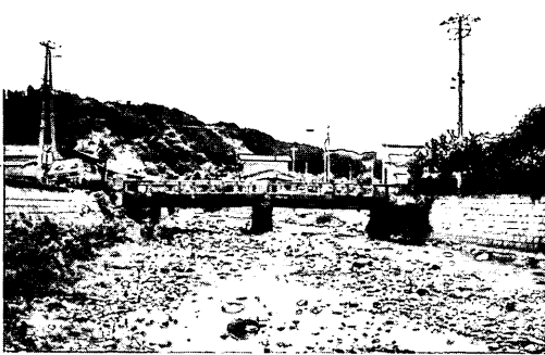
写真-5.33 北金ヶ沢港外の小童衣川 (橋桁の下まで水位が上昇した。)
