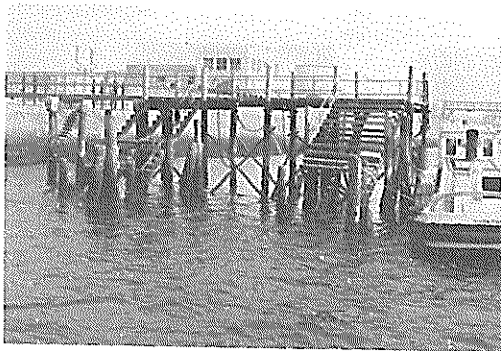
9号地南側棧橋全景(1)
