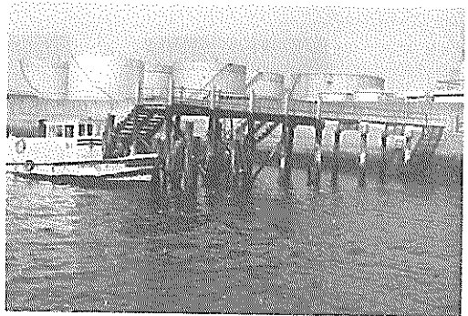
9号地南側棧橋全景(2)
