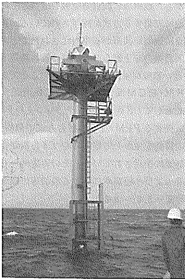
写真 - 5.8 小松島港海上観測塔観測局
