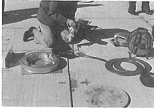
写真-3.6 灯器の取り付け状況
