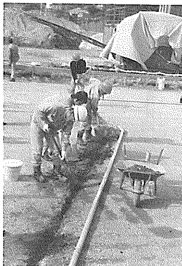
写真-3.1 配線溝の掘削状況
