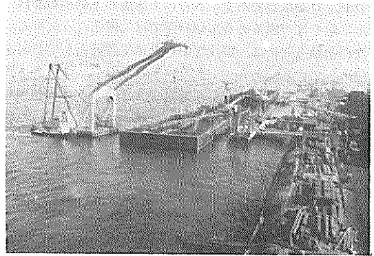
写真—3.4 艀装作業中
