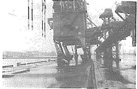
写真一 3.3.6 日和ふ頭-9m岸壁クレーンの脱輪と基礎の変形状況
