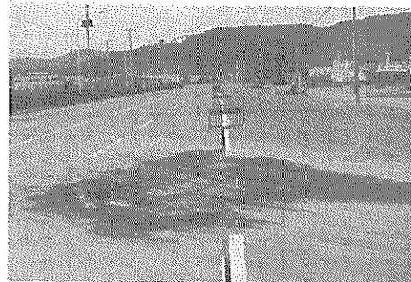
写真-4.1.6 -7m準備岸壁背後道路に生じたクラックおよび噴砂
