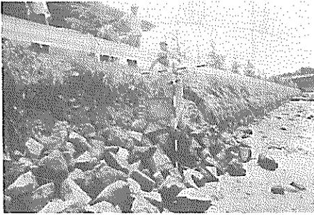
写真-3.1.5 中の島道路護岸・石積護岸崩壊
