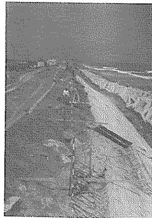
写真一三・三・一一 西浜海岸防潮堤被災状況（中央のポールは斜面のコンクリートの被災前天端位置を示す）
