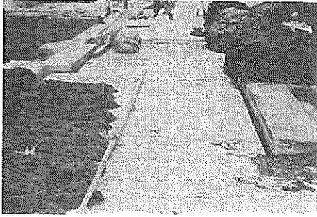
写真一三・四・五 大浜防波堤エプロンの沈下
