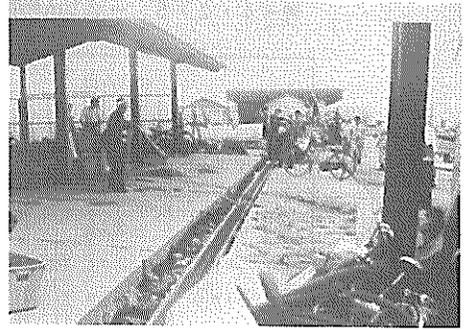
写真-4.2.14 加工場舗装とエプロンの目地の開き(No.6付近)
