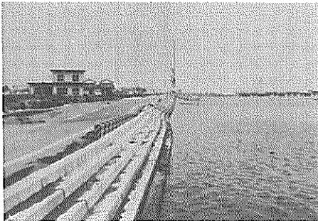
写真-4.2.30 壁体のすべり出しおよび沈下
