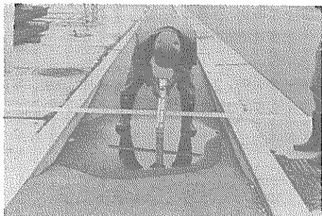
写真一三・九・二一 歩道の沈下(16 cm)
