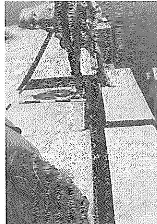
写真-3.1.12 石浜物揚場(B)上部工移動、舗装沈下
