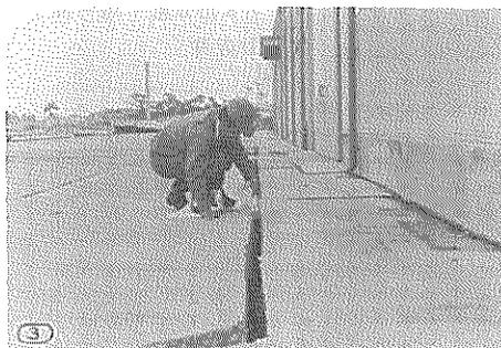
写真一三・九・8 上屋前面舗装の沈下および目地の開き
