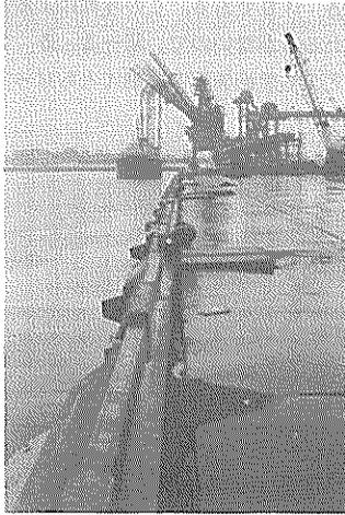
写真一 3.3.5 日和ふ頭-9m岸壁エプロンの沈下および矢板のはらみ出し状況
