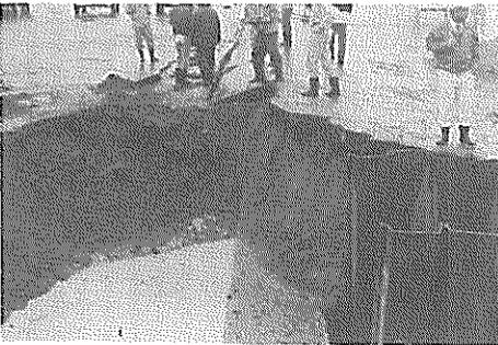
写真一三・三・2(b) 中島ふ頭一10m岸壁控え工付近の被災状況(写真下のコンクリート部が控え工の上部工である)
