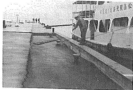
写真-3.8.3 観光さん橋 (-1.2 m) エプロンの沈下
