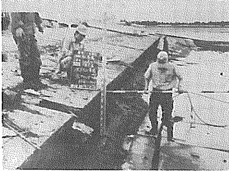
写真-4・2・36 斜面張りブロックの沈下およびすべり出し(No. 2 + 5.0 付近)
