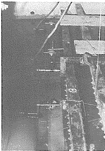
写真一 2.1 矢板天端変位測定状況
