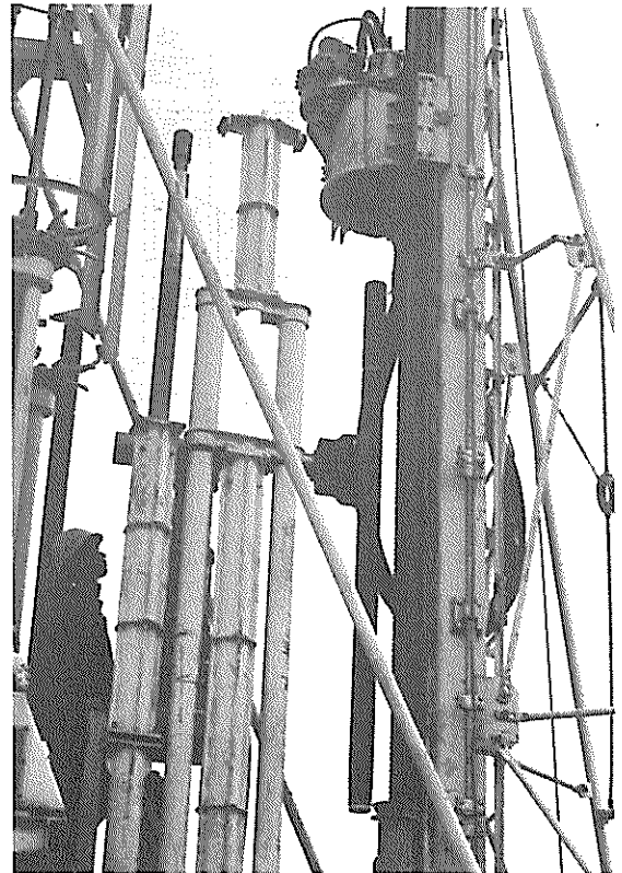
写-3.4.10 マニピュレータによるガイドロッドの把持状態とドリルヘッドの関係
