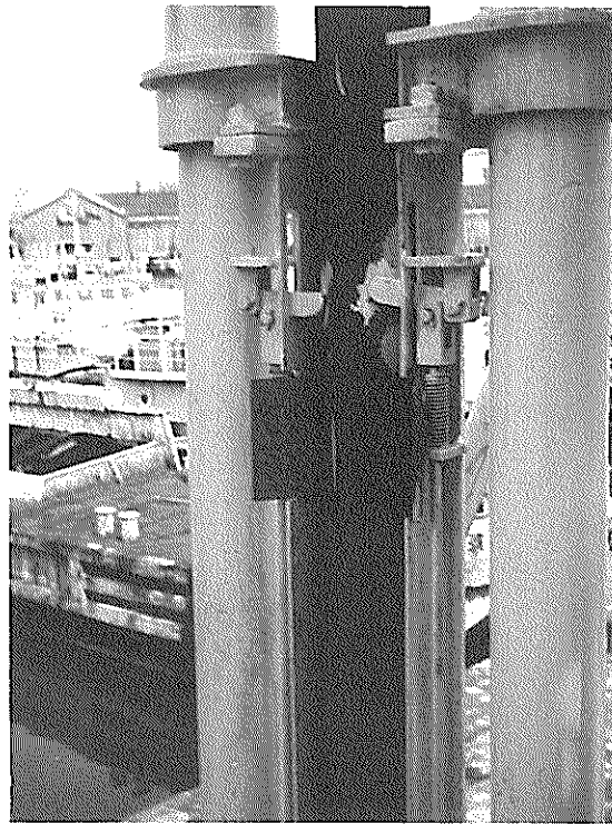
写-3.7.5 サンプルエレベータ用ゲートの増設状況
