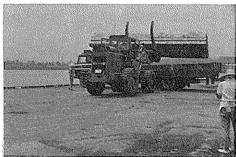
(c) トラックへの積み込み
