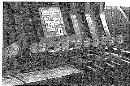
写真2・1 ジャッキ及び圧力計 (番号はフレーム番号)
