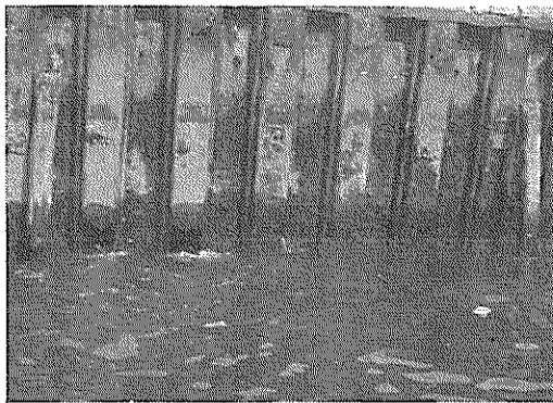
③ 海水面（+0.2 m）面上の鋼矢板面
