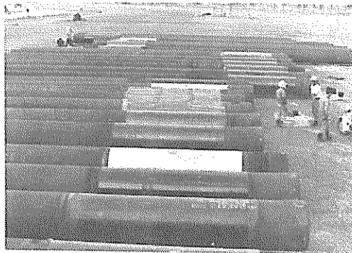
写真 2-10 現場へ運ばれた塗装鋼管杭
