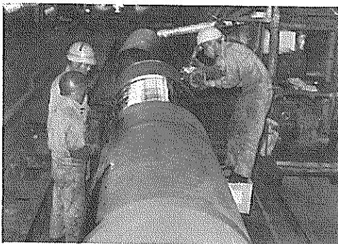
上塗り塗料の塗装 (刷毛塗り)
