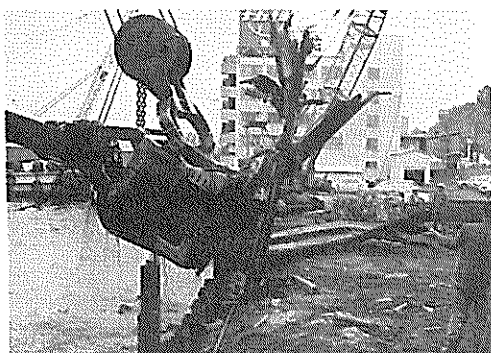
写真 3.3 鋼矢板の引き抜き状況
