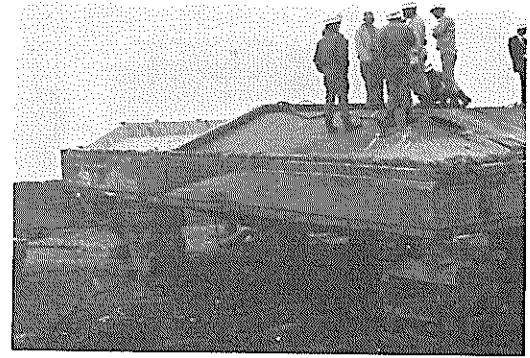
陸揚げされた扉船 (2)
