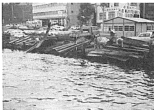
写真 3.3 鋼矢板の引き抜き状況
