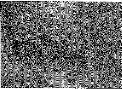
写真 3.2 引き抜き前の銅矢板腐食状況 (2)
