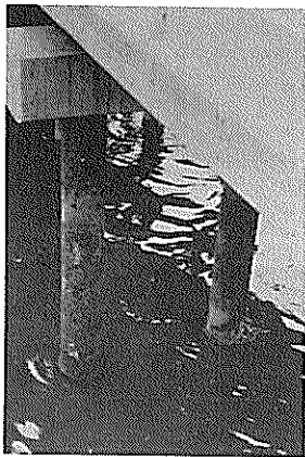
写真 2.1 東京港豊海水産埠頭、鋼管杭の腐食状況
