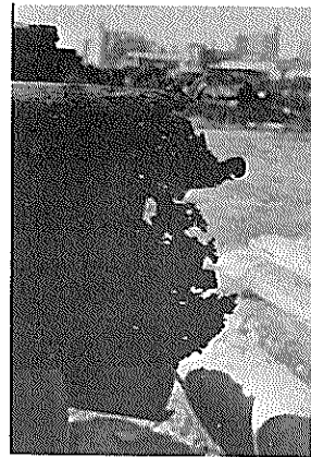
写真 2.2 平均干潮面直下付近の腐食穴の状況 (東京港豊海水産埠頭)
