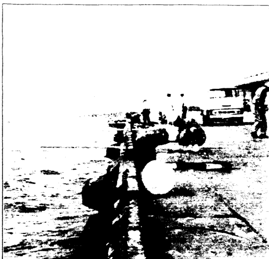
図3-11-2 計測器設置状況(写真)
