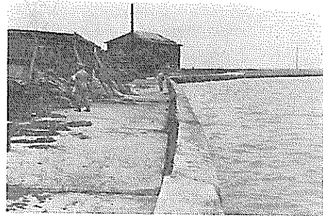
写真-2 野辺地港 -3.0m 物揚場の1968年十勝沖地震による壁体の傾斜
