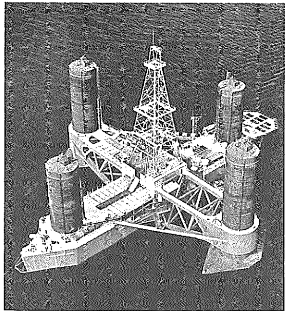
写真-9(a) (曳航中)
