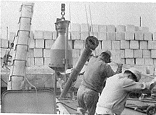
写真-4 コア・サンプラー取付作業状況
